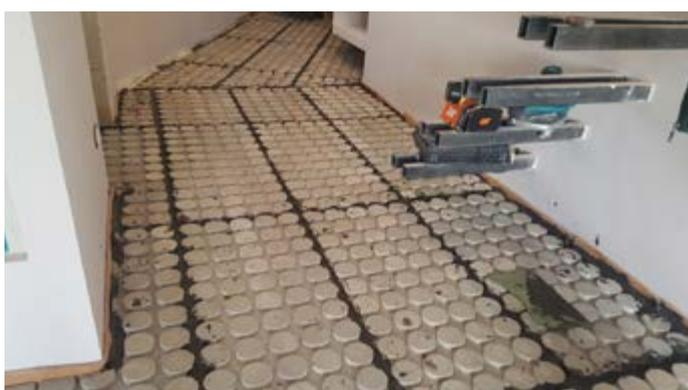
In caso di civile abitazione, bagni, ecc. si consiglia di sigillare il giunto di dilatazione con una malta cementizia bicomponente elastica ed impermeabilizzante **Mapelastic (Mapei)** nelle fughe. Lasciare circa 10 mm di spazio perimetrale come giunto di dilatazione tra la guarnizione morbida **FiberTherm® Sound-strip** ed i pannelli nei perimetri delle stanze.
