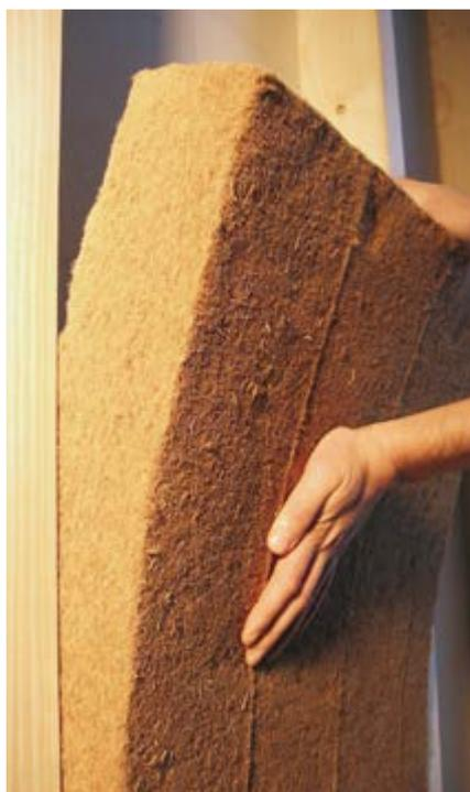
**Fibertherm flex 50** viene installato nelle cavità esercitando una pressione minima (tagliare il pannello con 10 mm di sovradimensionamento per facilitare il montaggio).
